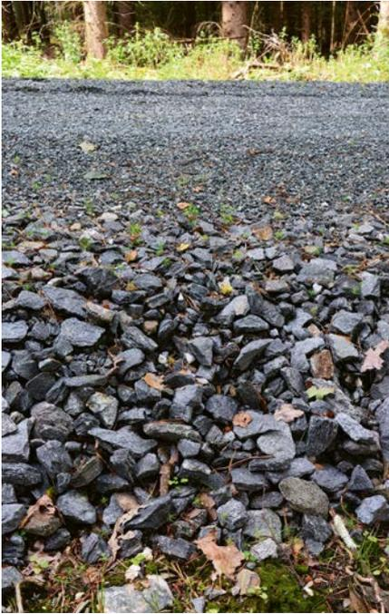
Abb. 3: Wegeaufbau mit Trag- und Deckschicht bzw. Verschleißschicht; Foto: Lukas Dörfel
