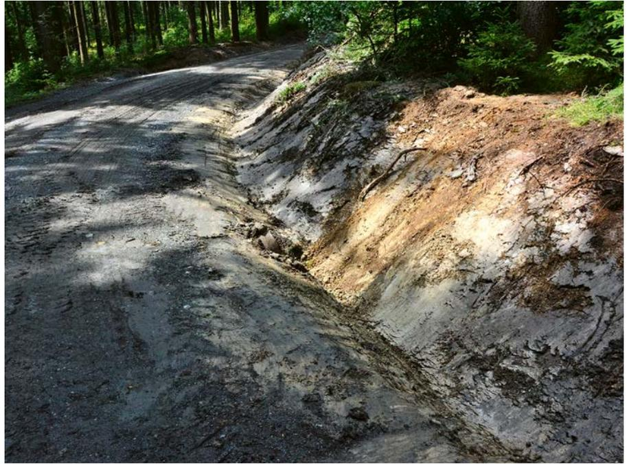
Abb. 4: Neuer Graben mit Durchlass zur Entwässerung am tiefsten Punkt; Foto: Lukas Dörfel
