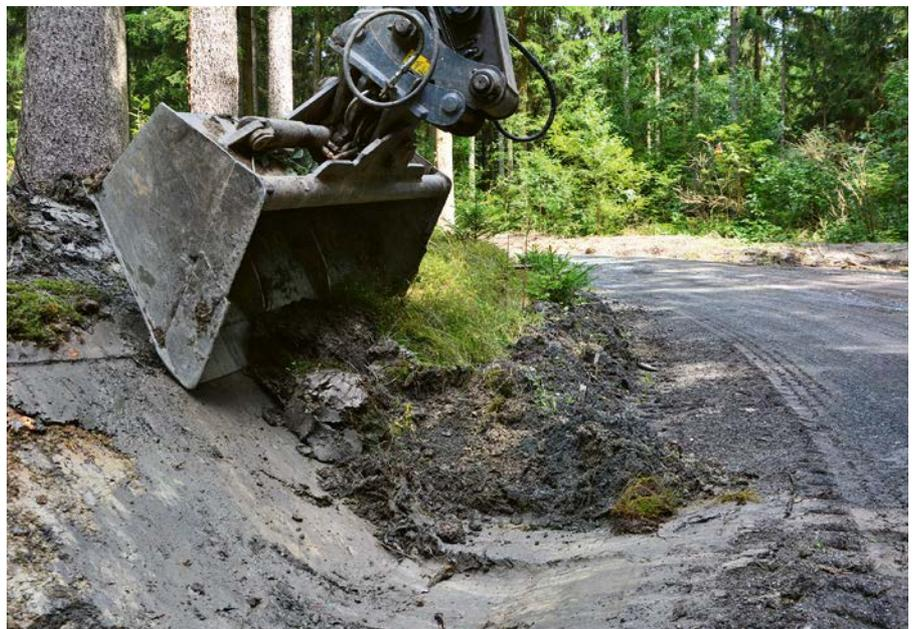
Abb. 5: Grabenanlage durch Radbagger; Foto: Lukas Dörfel
