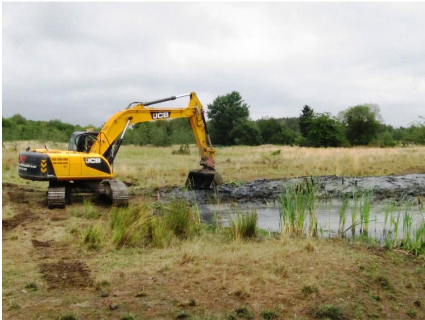
Abbildung 56: Bagger beim Durchführen einer Entschlammung
