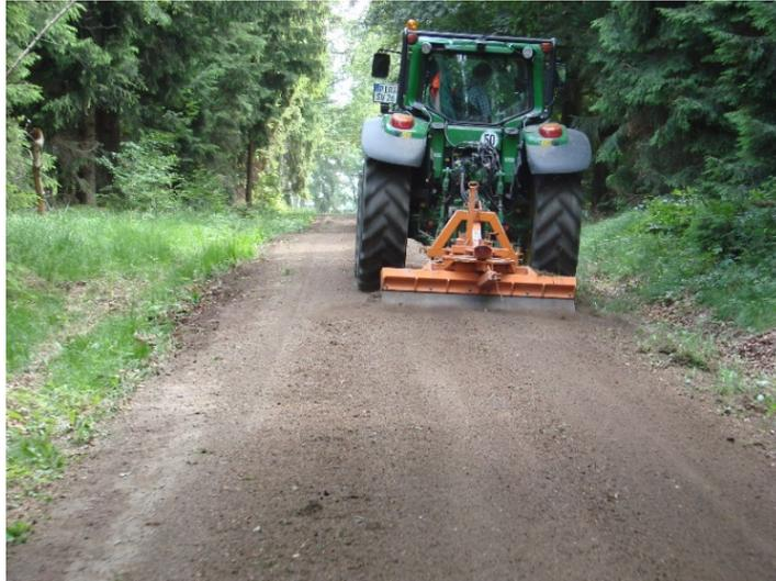
**Abbildung 5: Wegeunterhaltung mit Schlepper und Anbaugerät; diese Maßnahme ist kein Eingriff**
