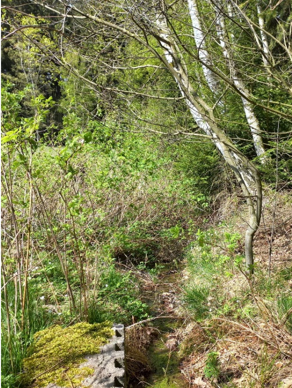
Abbildung 76: Von Himbeeren überwachsener Bachabschnitt
