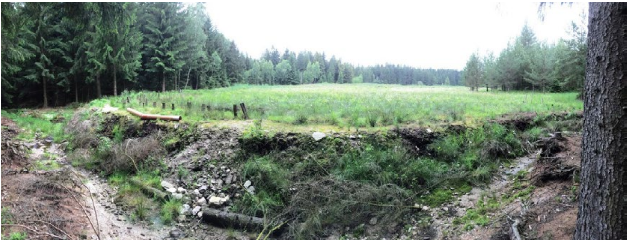
Abbildung 1: Das Jahnsgrüner Moor 2018. Blick von Südosten auf den beschädigten Enddamm (Foto: Simon Franz)
