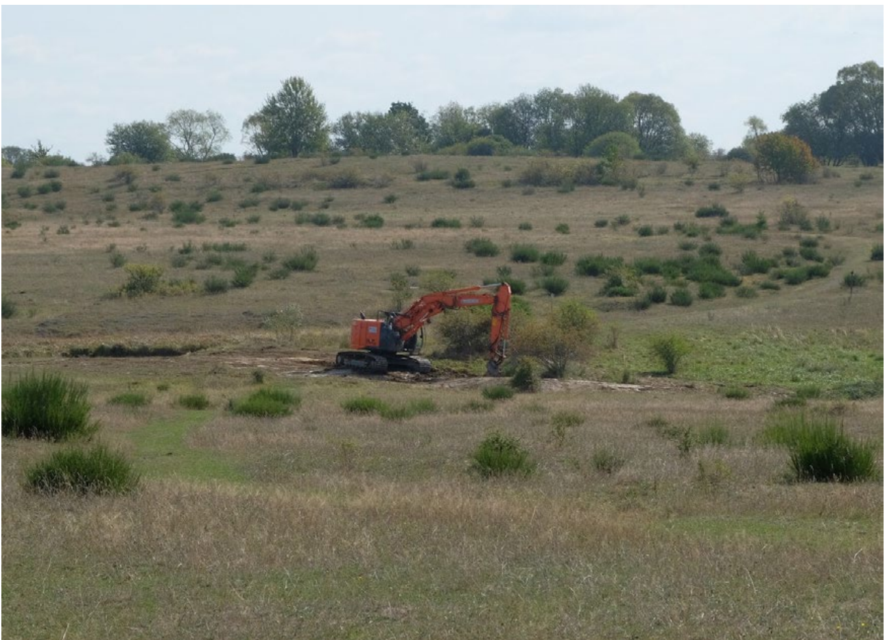
Abbildung 3: Ohne Technik geht es nicht. Baggerarbeiten zur Renaturierung des Laichgewässers an Sponers Graben im NSG „Großer Weidenteich“
