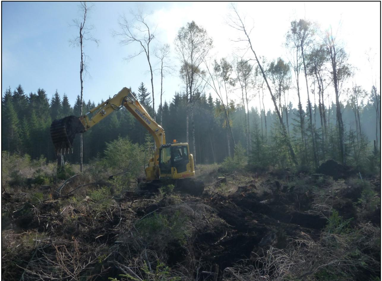
**Abbildung 21: Grabenverfüllung von ehemaligen Entwässerungsgräben am Göltzschgesprenge zur Wiederherstellung eines moortypischen Wasserregimes auf der Fläche**
