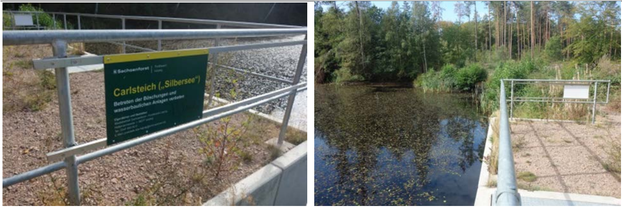
Abbildung 24: Neues Ständerbauwerk des Flächennaturdenkmals Carlsteich
