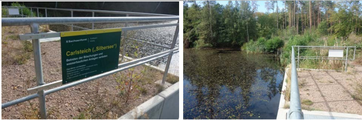
Abbildung 24: Neues Ständerbauwerk des Flächennaturdenkmals Carlsteich
