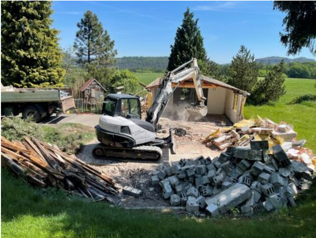
Abrissarbeiten der Firma Schober Bau GmbH am 19.5.22, Foto: Uwe Borrmeister
