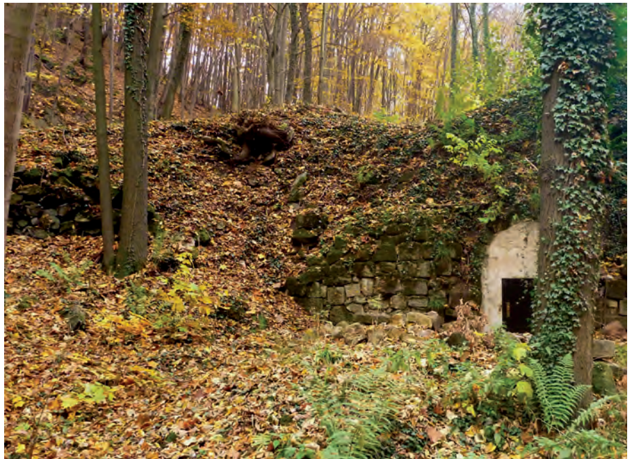
Abb. 1: Fledermausquartier Kalkofen (Sicherung einsturzgefährdeter Decke), Foto: Susann Ludorf (FBZ Kamenz)
