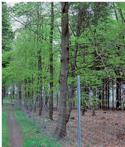
Knotengeflecht mit Z-Profil-Stahlpfählen
