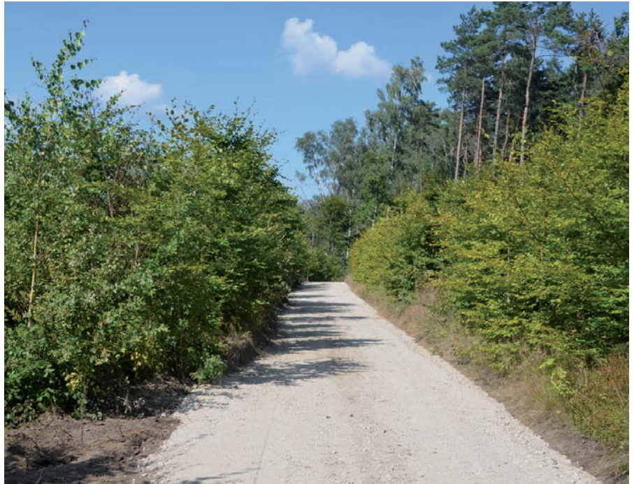
Holzabfuhrweg nach Abschluss der Instandsetzungsmaßnahme
