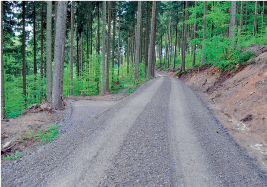
Gefördertes Wegebau-Projekt im Stadtwald Marienberg zur Erschließung eines ca. 60 ha großen Waldgebietes
